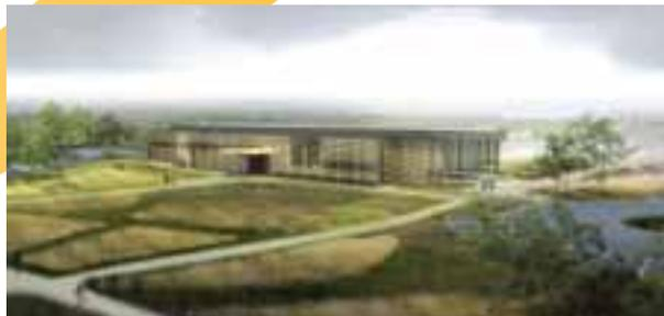
■ LA TOITURE VEGETALISEE permet la régulation des eaux de pluie en retenant 50 à 100% des précipitations ce qui évite l'engorgement des réseaux publics. Elle apporte un confort thermique et phonique (limite les déperditions et/ou apports thermiques importants) ainsi qu'une augmentation de l'inertie thermique du bâtiment. Enfin, elle assure la protection des membranes d'étanchéité.
