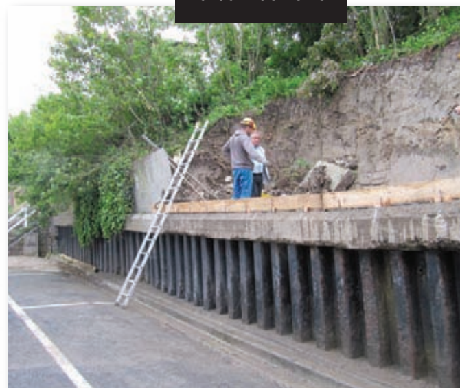
Travaux rue Feine
