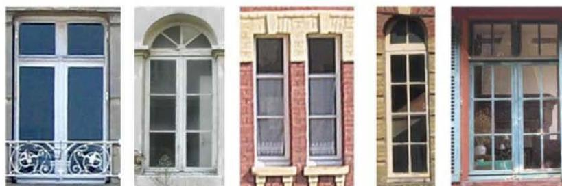
Châssis simple à grands carreaux et imposte fixe      Châssis à deux ouvrants à grands carreaux et imposte fixe      Châssis jumelés à simples ouvrants et à grands carreaux      Châssis à simple ouvrant à petits carreaux et imposte cintrée      Châssis à deux ouvrant à petits carreaux et imposte fixe
