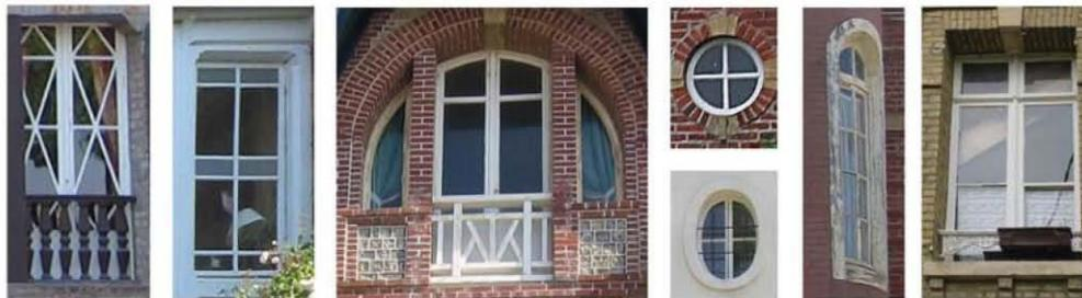
Châssis double à carreaux géométriques      Châssis simples à carreaux géométriques et verres granités      Fenêtre dite "thermale" à châssis fixes et ouvrants cintrés      Oculi à simple ou double ouvrants      Châssis cintré      Fenêtres d'escalier avec "guchet" ouvrant
