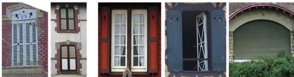
Volets persiennés avec lambronnage en...      Volets persiennés en parterre plein en...      Volets pleins pliants      Volets pleins      Volets roulants intégrés
