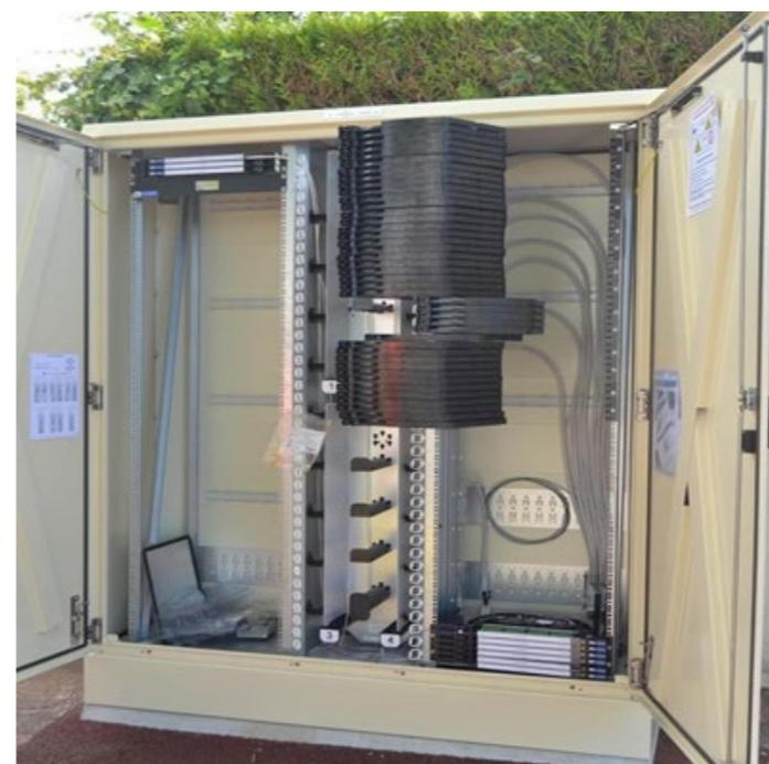
Il a été procédé ces derniers mois à l'installation de tiroirs de liaisons fibre optique dans une armoire servant de point de connexion pour les opérateurs qui viennent y connecter les habitants abonnés.
